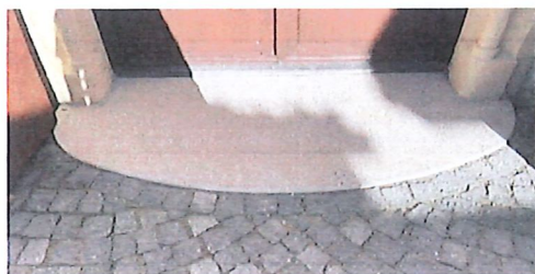
Nouveau seuil de porte
