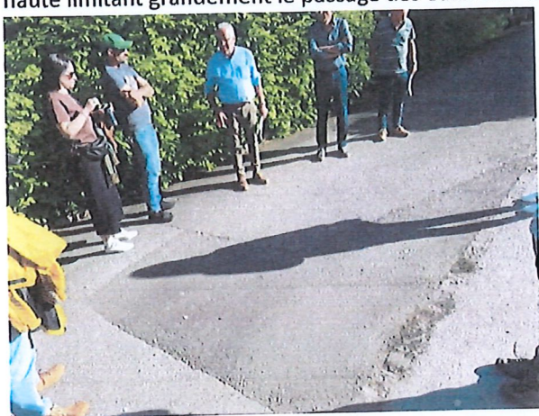
Canalisation rue du Moulin
