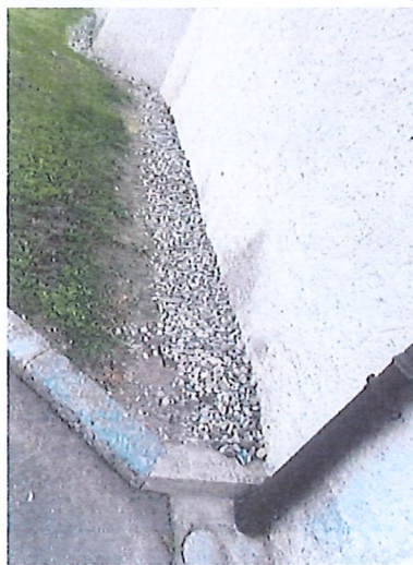
Drainage mur nord
